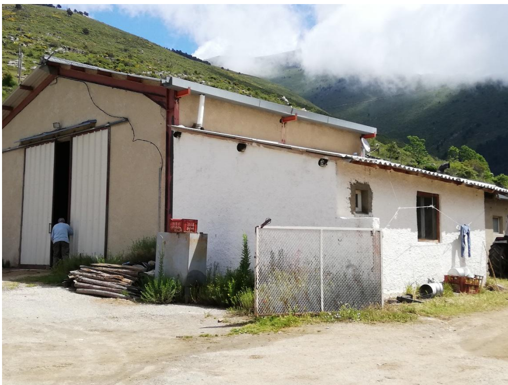
Pignon ouest : entrée stockage / annexe logement
